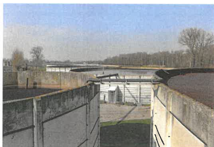
Door de zwaartekracht loopt de vloeistof van de verwerkingsilo's naar de opslagtanks voor het effluent. Het slib blijft zodoende achter.
